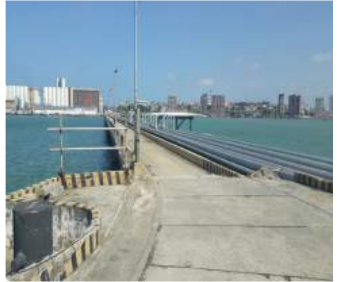
Foto 142: Vista da plataforma e da ponte
