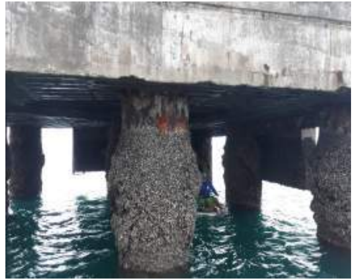
Foto 134: Laje com perda de recobrimento e armadura oxidada
