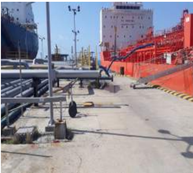
Foto 147: Vista plataforma de atracação
