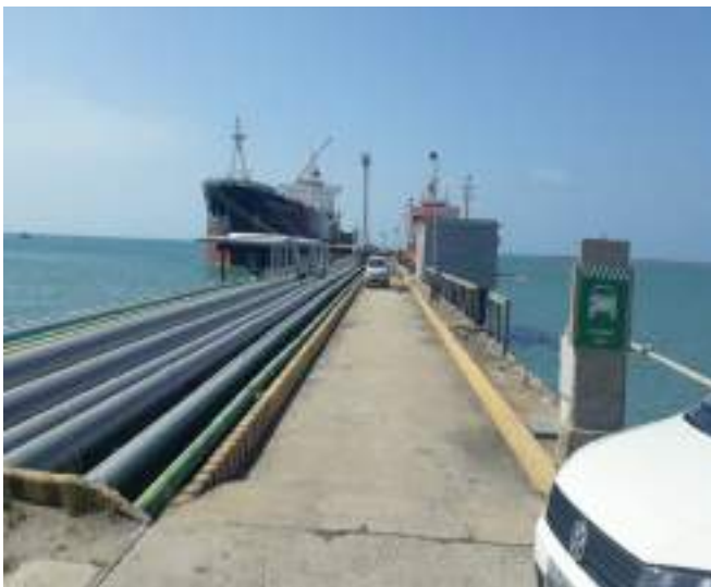
Foto 155: Vista ponte com guarda-corpos avariados
