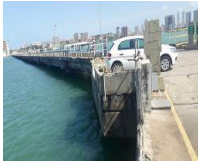
Foto 146: Vista vigas do lado direito da ponte
