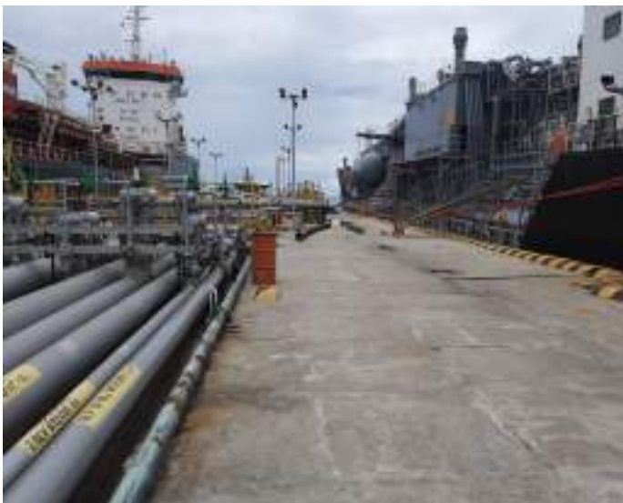
Foto 143: Vista da plataforma de atracação
