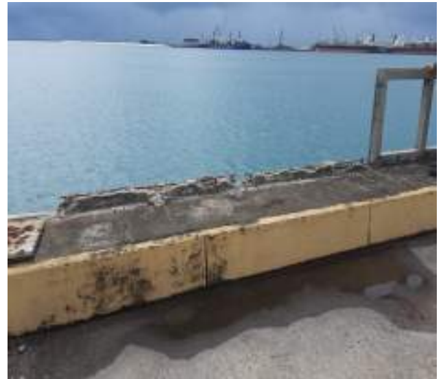
Foto 130: Guarda-corpo quebrado
