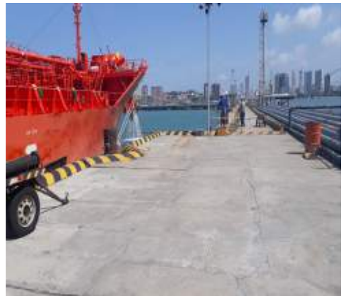
Foto 148: Vista plataforma de atracação
