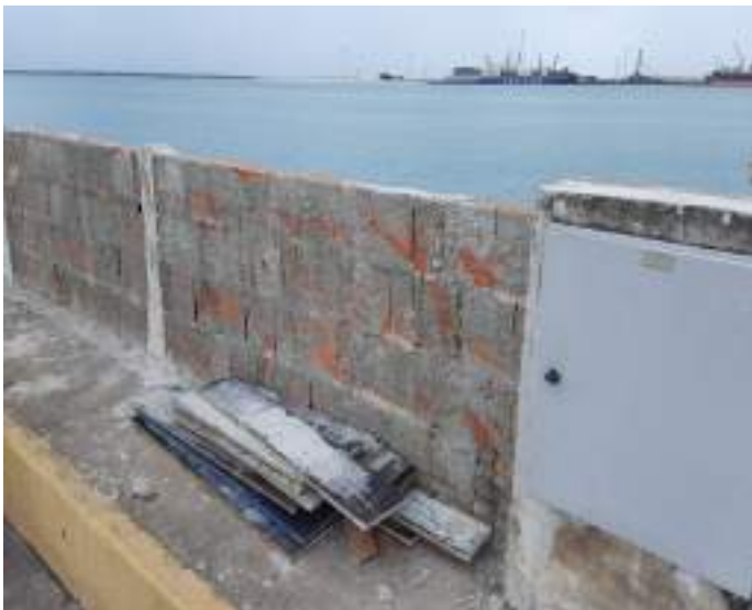
Foto 131: Novo Guarda-corpo que está sendo executado
