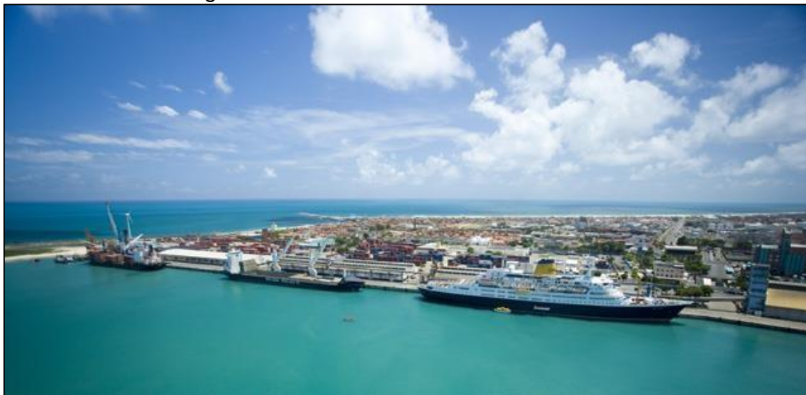
Figura 1: Vista aérea do Porto de Fortaleza
