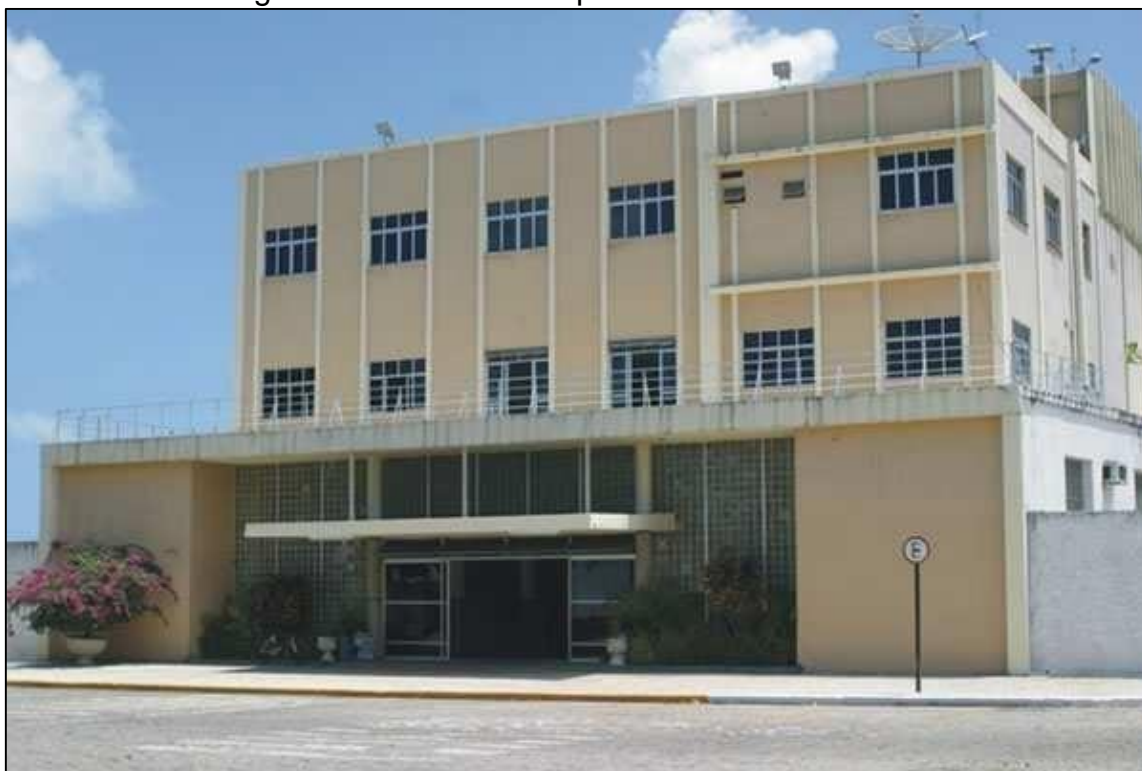
Figura 2: Prédio da Companhia Docas do Ceará
