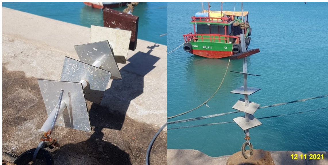
Figura 2 – Confeção e instalação das placas em novembro/2021 no Porto de Fortaleza/CE
