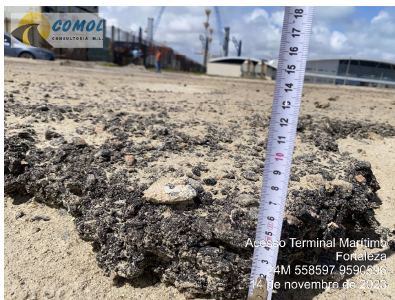
Foto 06 - Revestimento em CBUQ – 5,00 cm
