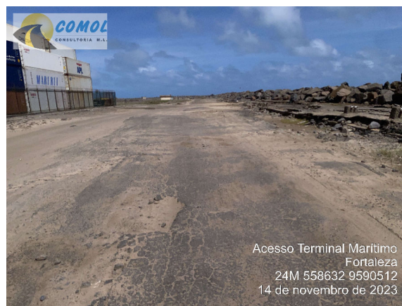
Foto 07 – Revestimento Desgastado.
