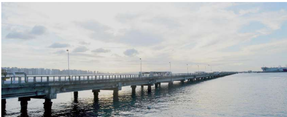
Figura 32 – Sistema dutoviário do Porto de Fortaleza Fonte: Imagem obtida durante visita técnica (2019)
