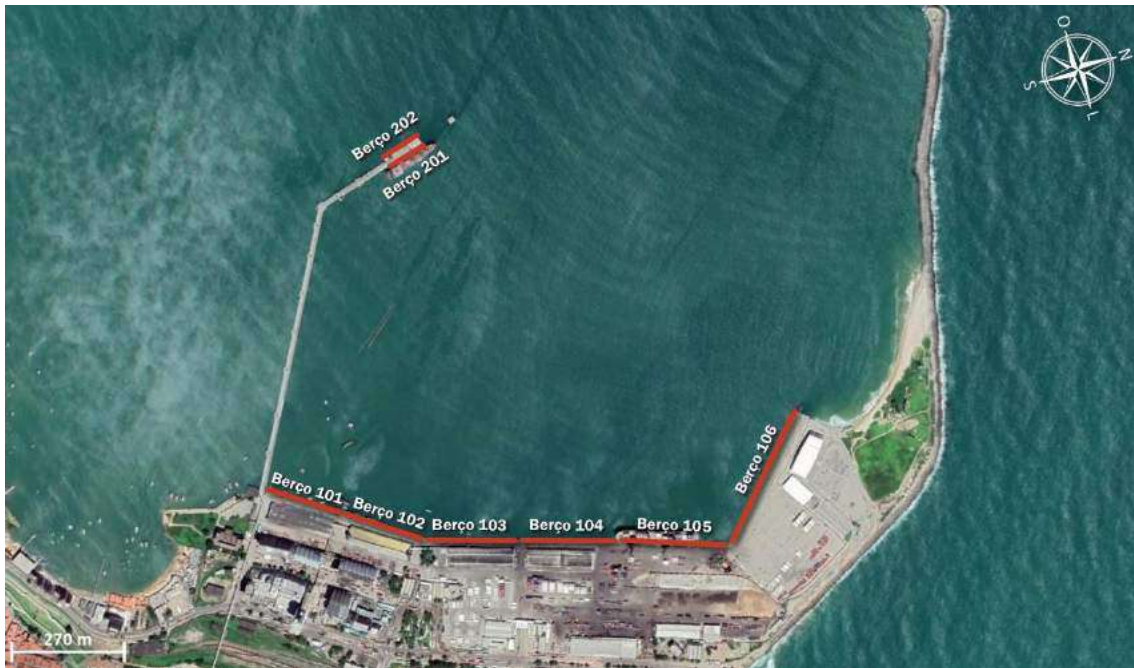
Figura 25 – Infraestrutura de acostagem do Porto de Fortaleza Fonte: Google Earth (2019). Elaboração: LabTrans/UFSC (2019)
