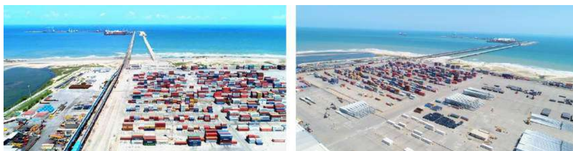
Figura 50 – Pátio Onshore do Terminal Portuário do Pecém Fonte: Imagens fornecidas pela CIPP (2019); CIPP (2019a). Elaboração: LabTrans/UFSC (2019)
