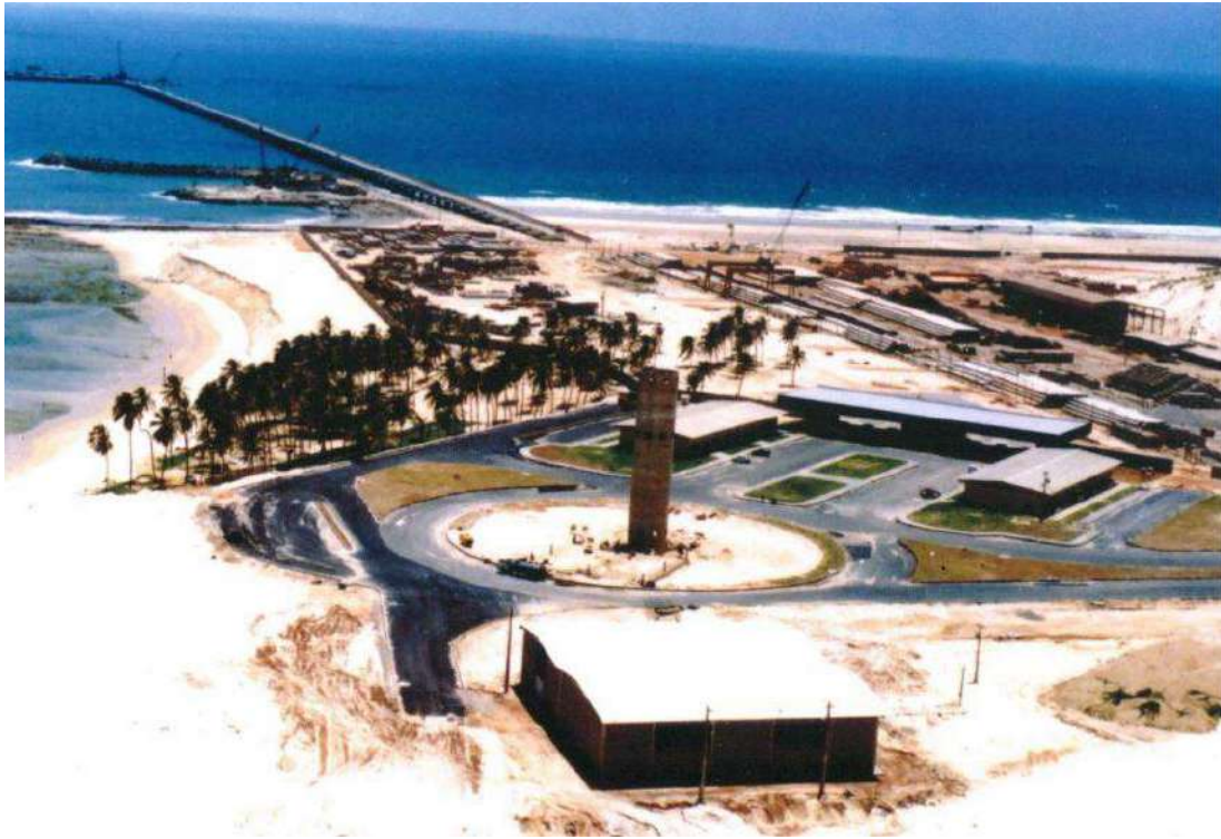
Figura 135 – Obras do Terminal Portuário do Pecém (1999) Fonte: Rodrigues e Souza Filho (2007).
