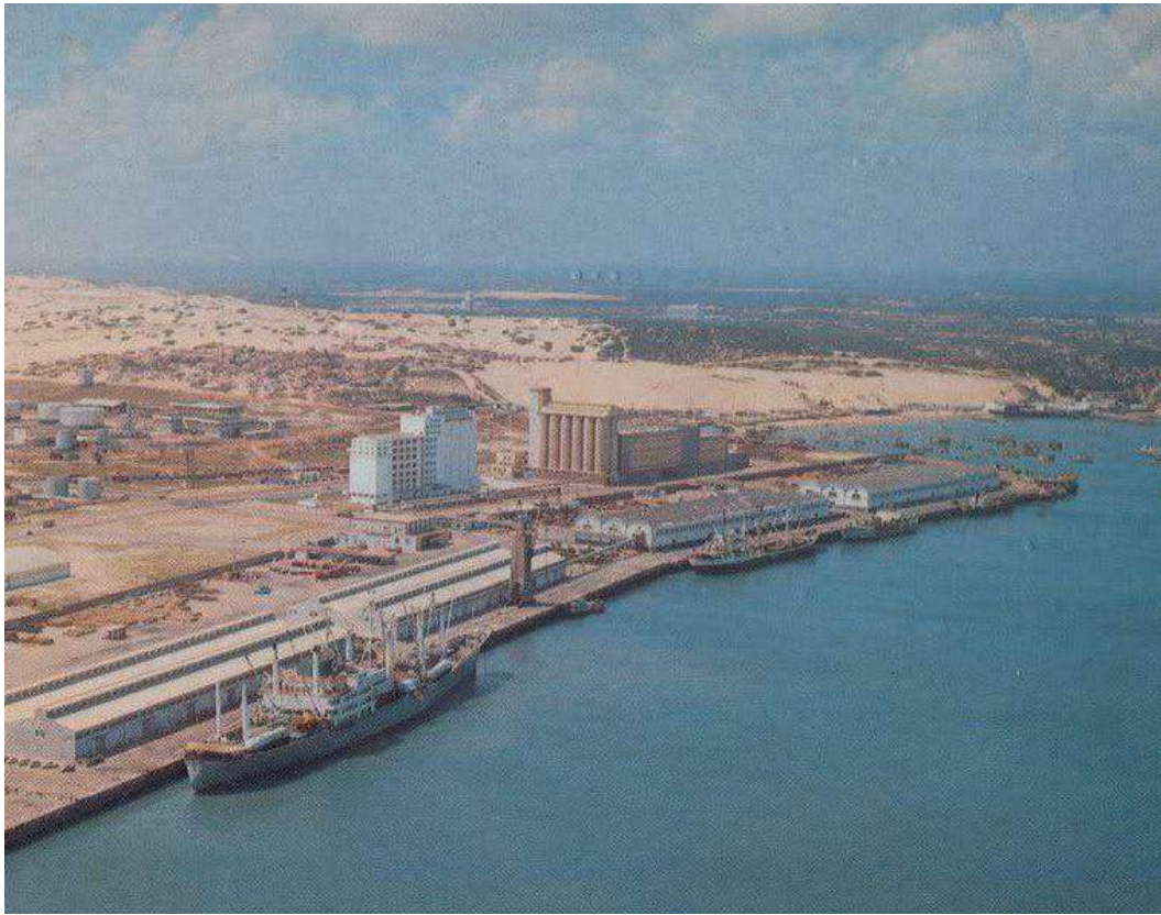
Figura 134 – Construção do Porto de Fortaleza (1960) Fonte: Garcia (2012).
