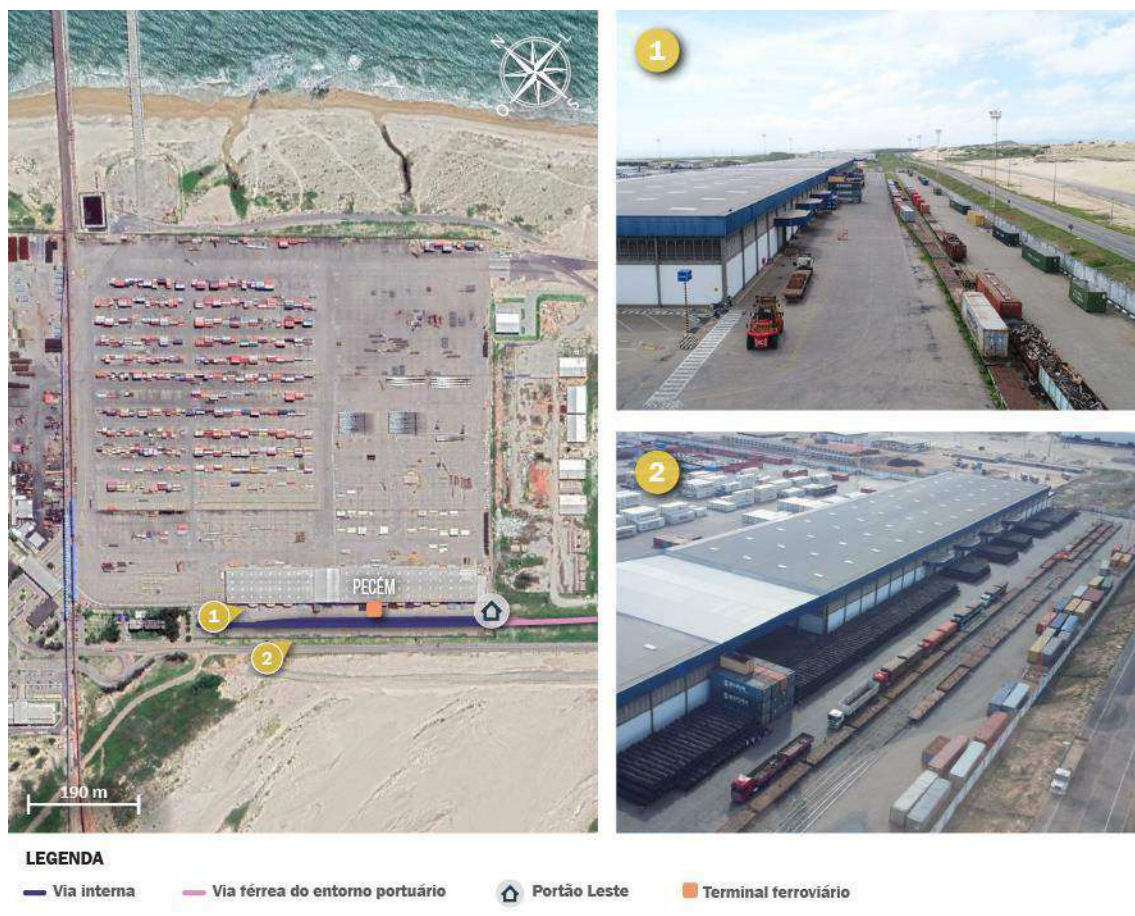
Figura 111 – Vias ferroviárias situadas dentro da área do TPP
