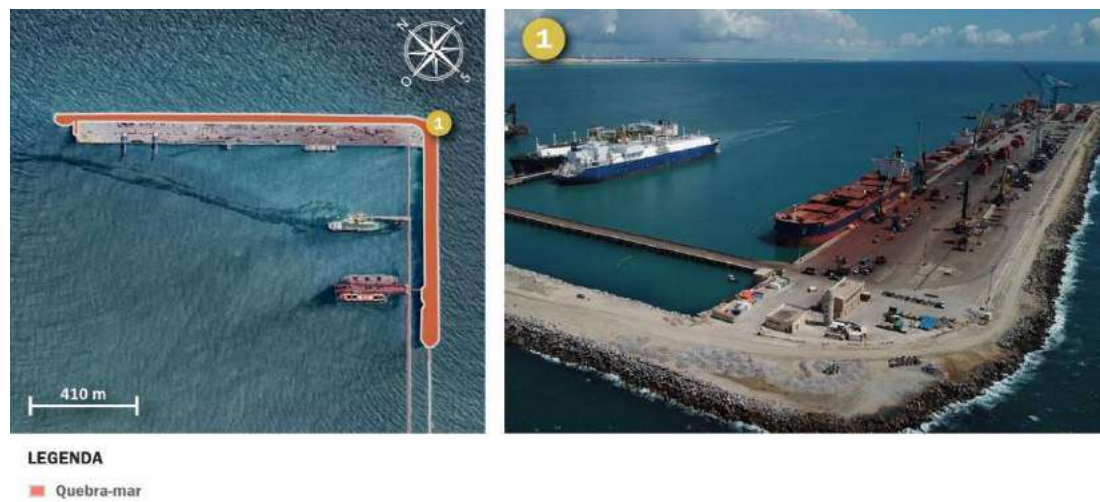
Figura 45 – Quebra-mar do Terminal Portuário do Pecém Fonte: Google Earth (2019). Elaboração: LabTrans/UFSC (2019)
