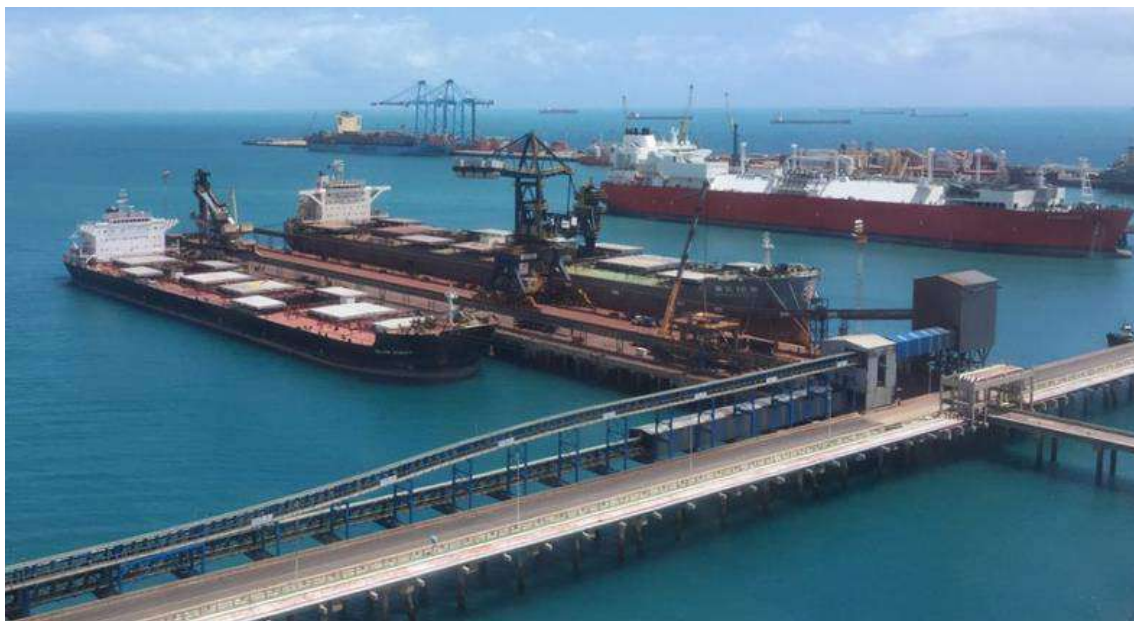
Figura 53 – Sistemas de correias transportadoras do Terminal Portuário do Pecém Fonte: Imagens fornecidas pela CIPP (2019)
