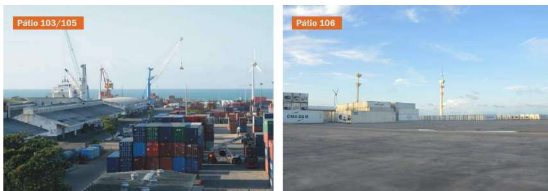
Figura 30 – Pátios do Porto de Fortaleza Fonte: Google Earth (2019) e Brasil (2015). Elaboração: LabTrans/UFSC (2019)
