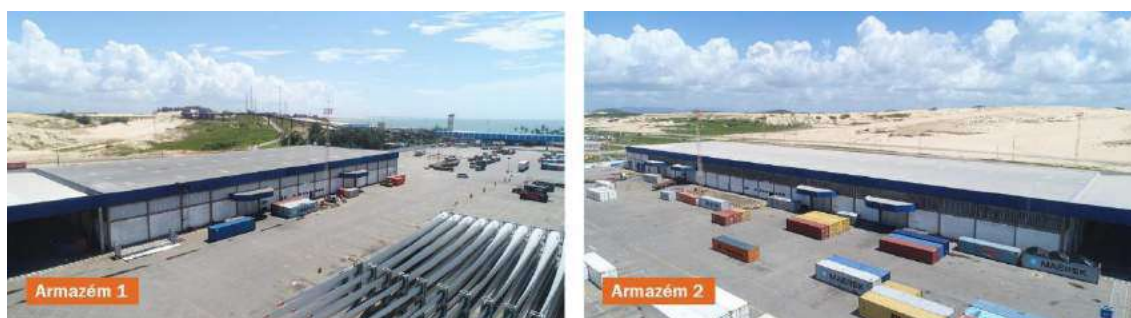
Figura 49 – Armazéns do Terminal Portuário do Pecém Fonte: Imagens fornecidas pela CIPP (2019). Elaboração: LabTrans/UFSC (2019)
