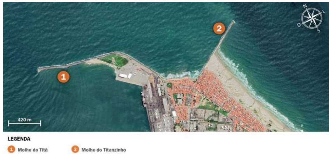
Figura 23 – Molhes de abrigo do Porto de Fortaleza Fonte: Google Earth (2019). Elaboração: LabTrans/UFSC (2019)
