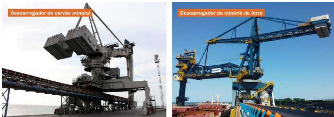
Figura 52 – Descarregadores de granel do Terminal Portuário do Pecém Fonte: Imagens fornecidas pela CIPP (2019). Elaboração: LabTrans/UFSC (2019)
