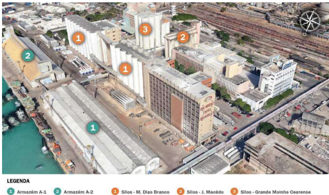
Figura 28 – Armazéns e silos para a armazenagem de trigo no Porto de Fortaleza Fonte: Google Earth (2019) e Brasil (2015). Elaboração: LabTrans/UFSC (2019)
