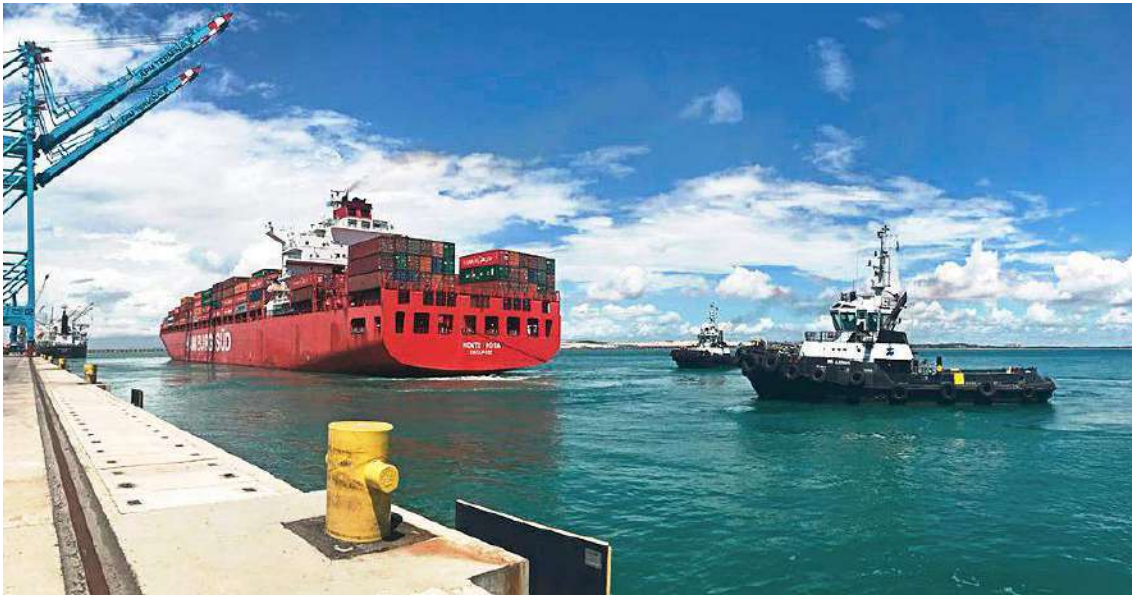
Figura 47 – Cabeços de amarração e defensas do TMUT no Terminal Portuário do Pecém Fonte: CIPP (2019a). Elaboração: LabTrans/UFSC (2019)
