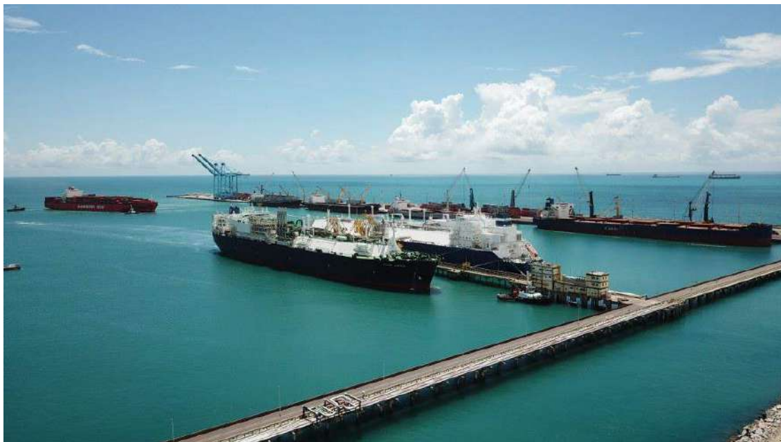
Figura 65 – Operação de GNL no Píer 2 do Terminal Portuário do Pecém Fonte: Imagem fornecida pela CIPP (2019)
