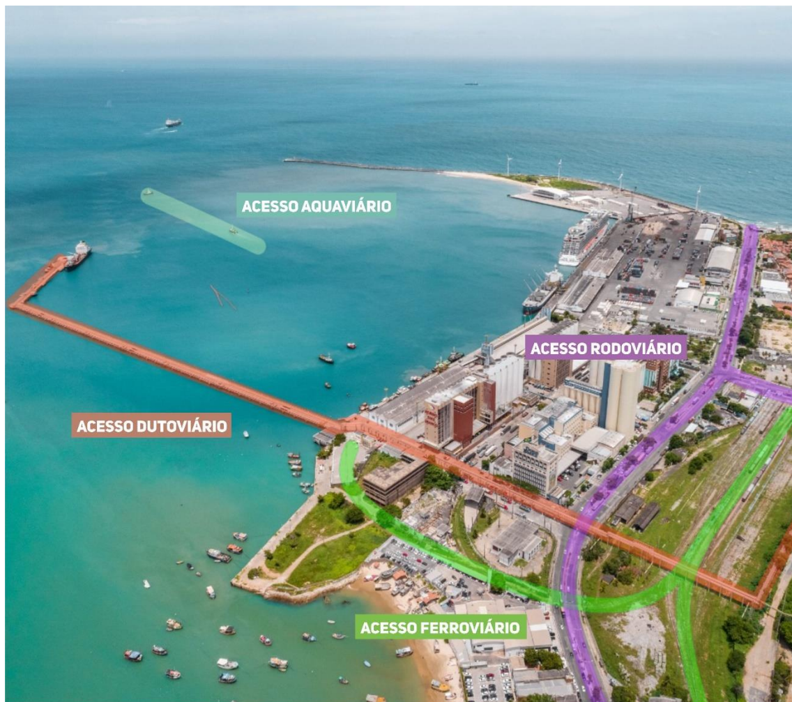
Figura 3 – Acessos Porto de Fortaleza.
