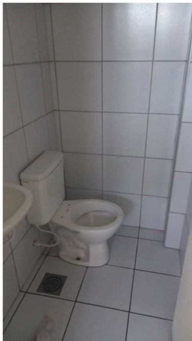
Foto 10: instalações do banheiro
