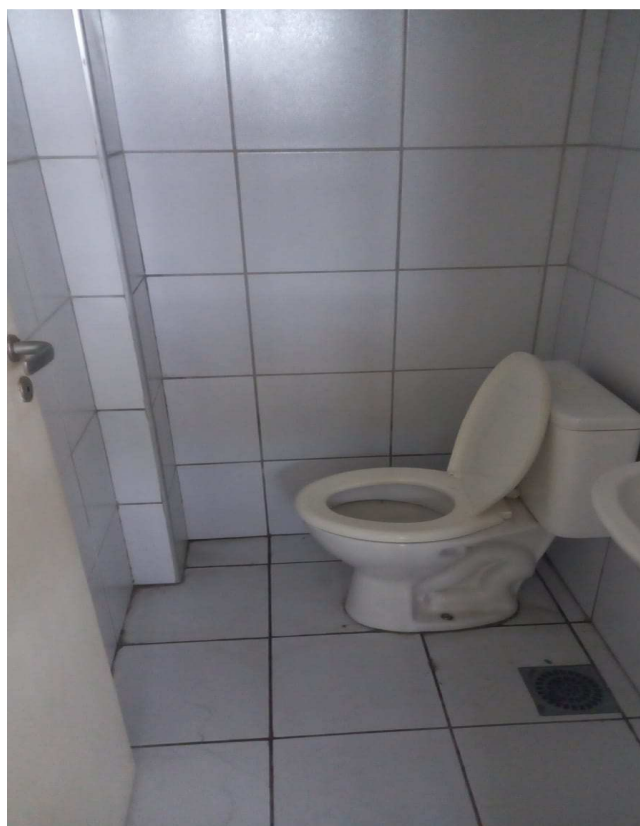
Foto 21: instalações do banheiro
