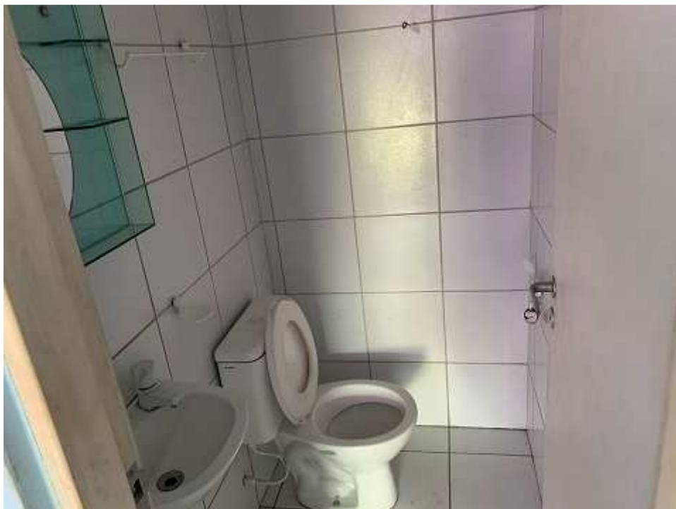
Foto 8: instalações do banheiro
