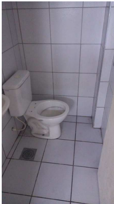
Foto 15: instalações do banheiro
