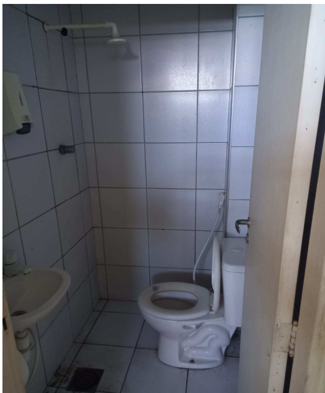
Foto 27: instalações do banheiro
