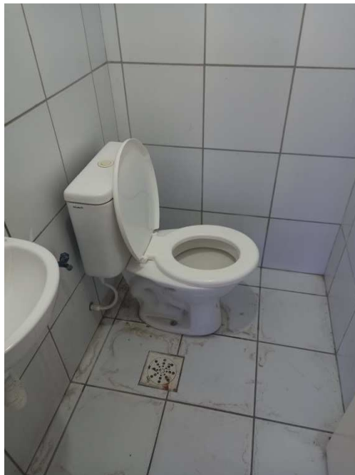
Foto 3: instalações do banheiro
