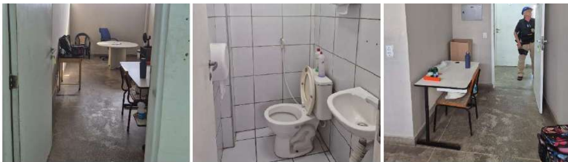
FIGURA 5 - SALA Nº 06 - PORTA DE ACESSO E BANHEIRO
