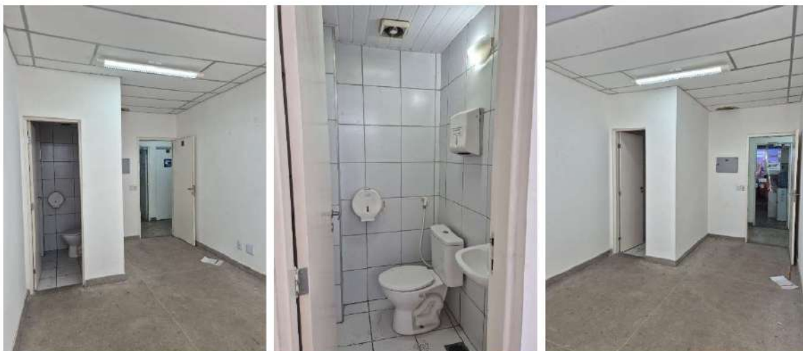
FIGURA 6 - SALA Nº 08 - PORTA DE ACESSO E BANHEIRO
