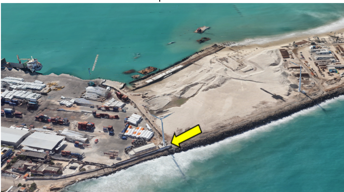
Figura 3: Vista panorâmica da Praia Mansa, destacando a localização do aerogerador nº 4 nas proximidades do ponto de instalação do Hi-Vol, identificado pela seta amarela.
