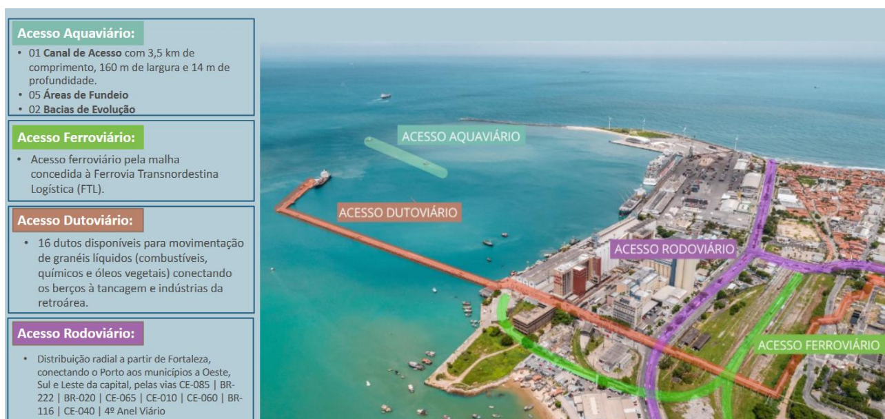
Figura 3 - Acessos do Porto de Fortaleza
